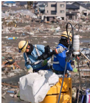
配電設備復旧作業
