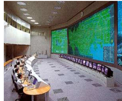
交通管制センター
