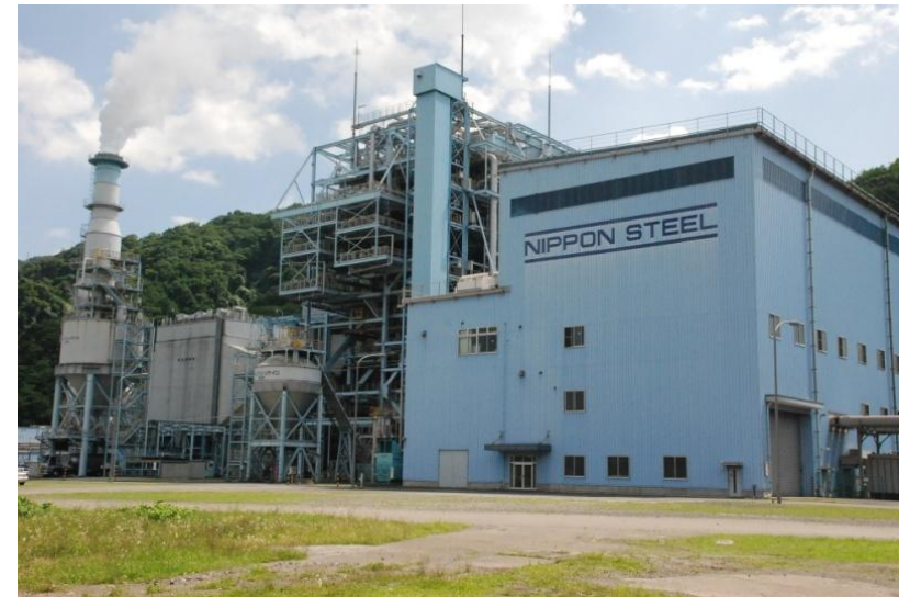
7月1日に営業運転を再開した釜石IPP
